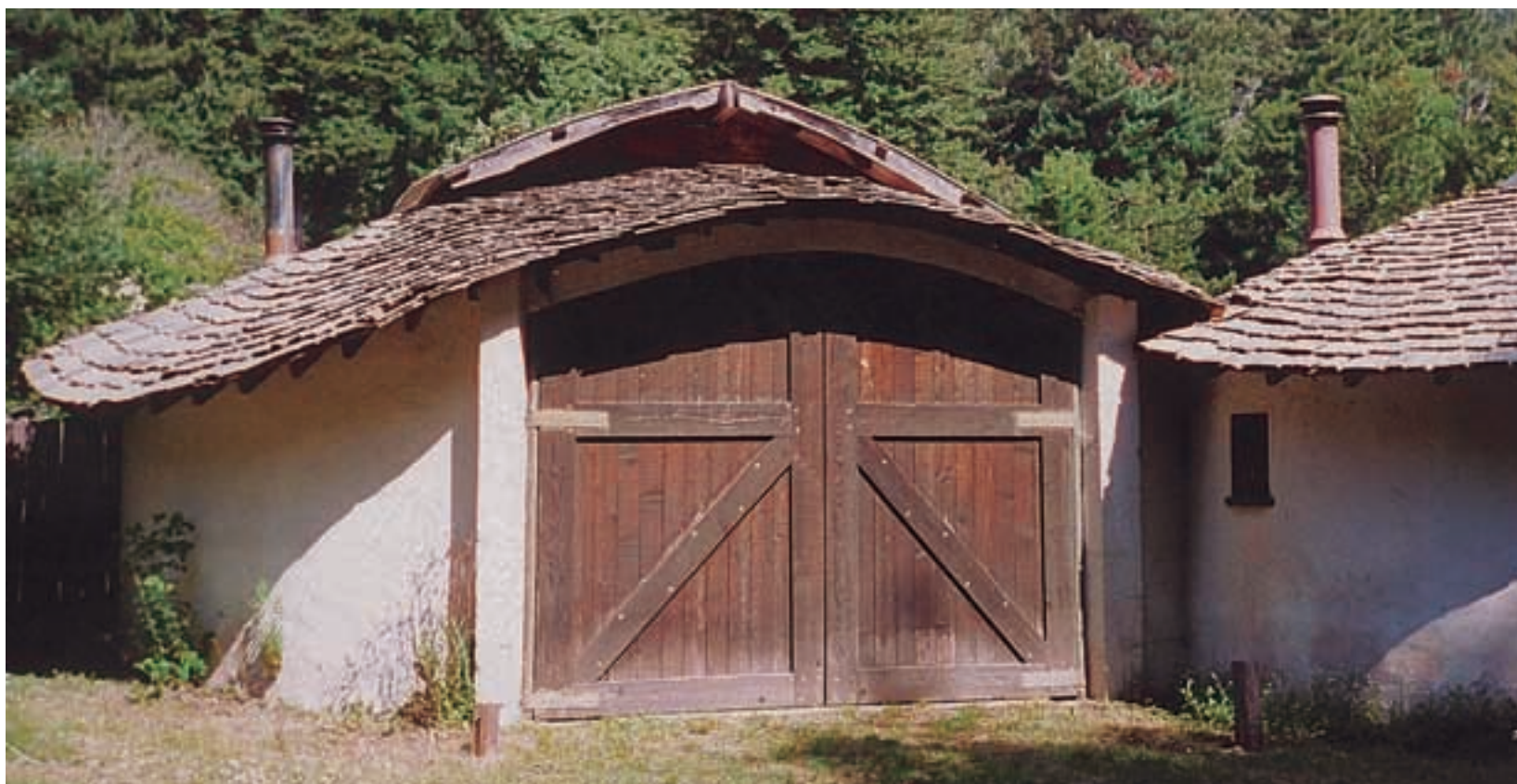
Le magasin de Louie, avec des murs en béton banché.
