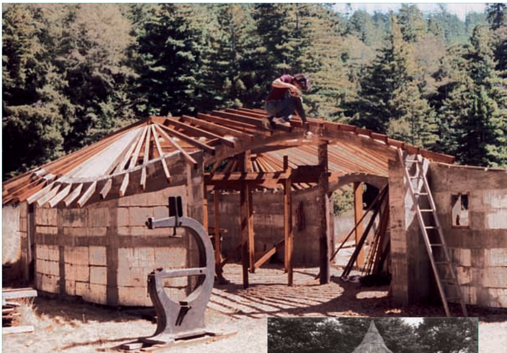
En train de bâtir la charpente du toit du magasin. Les murs extérieurs sont couverts d'une isolation de mousse. Des lignes foncées verticales et horizontales montrent la structure en grille de la bâtisse, avec quatre barres en acier de 13 mm de diamètre (l'isolation est à l'extérieur de la structure). Voir les dessins en dessous pour des détails.
