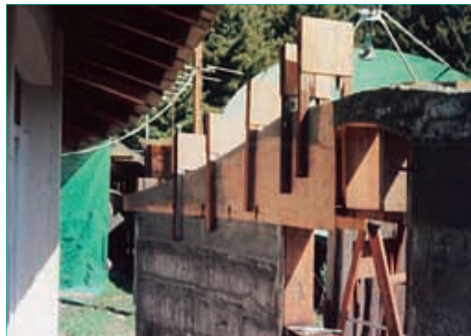
Le coffrage d'une poutre sur la ceinture supérieure en cours de coulage. Remarquez comment les grandes « pincés à linge » glissent sur les strates déjà coulées.
