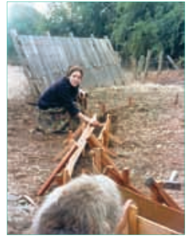
Carrie, la fille de Louie, met des séparations dans les coffrages des fondations.
