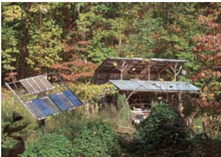
La structure de poteaux et poutres a été construite à partir d'arbres abattus par une tempête de grêlons. L'espace à l'étage est utilisé pour se rencontrer et pour dormir; en bas se trouve un atelier pour le travail des céramiques et du verre.
