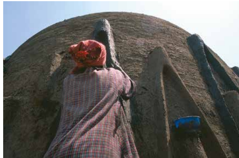
Application de la couche de renforcement et finition des reliefs.
