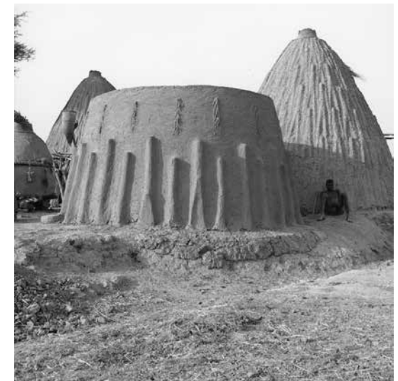
Case en construction avec accroches pour les modénatures nervurées à venir. Photographie Michel Kalt, 1950.
