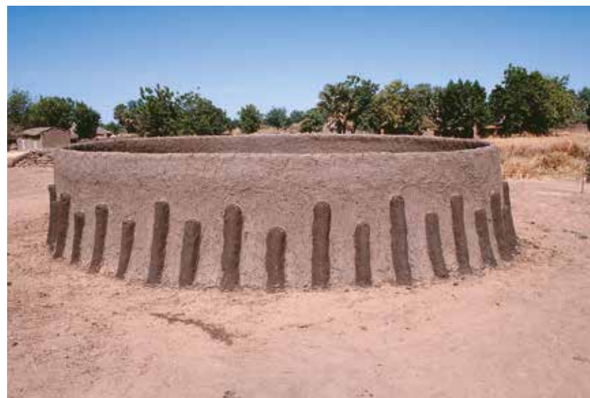
Vue générale sur une première rangée de pose-pieds avant séchage.
