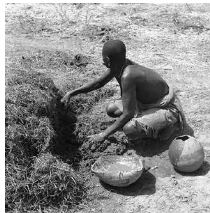
Phases de construction d'une case obus en 1950. Photographie Michel Kalt.
