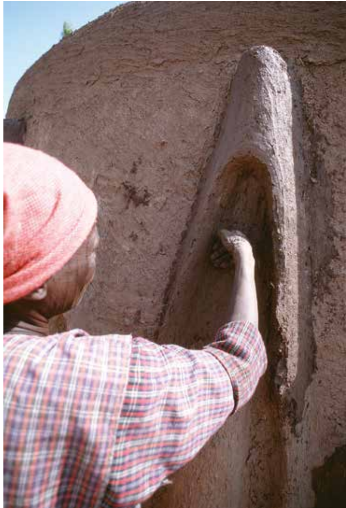
Application de la couche de renforcement et finition des reliefs.
